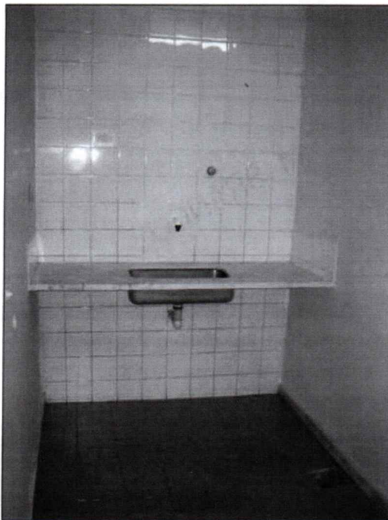
Figura 20: Copa 1º pavimento.
