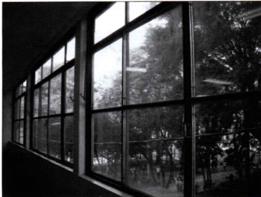
Figura 8: Janelas da fachada.
