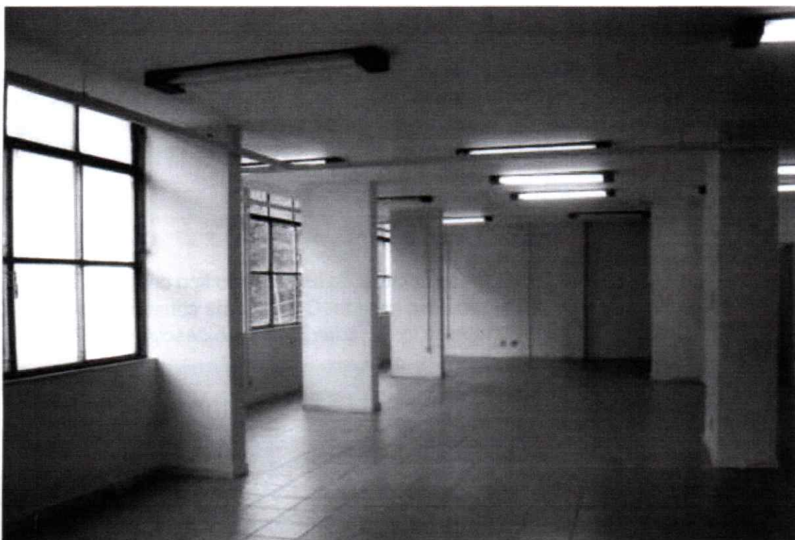
Figura 1: Pilares, vigas, teto e alvenarias em perfeito estado de conservação, recém reformados.
