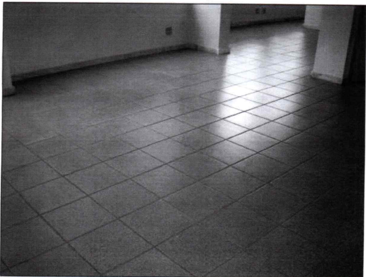
Figura 3: Piso cerâmico em excelente estado.
