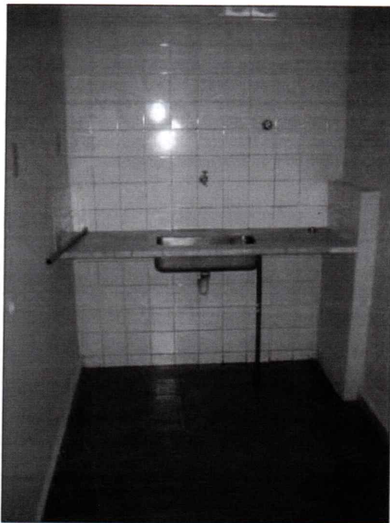
Figura 21: Copa 2º pavimento.
