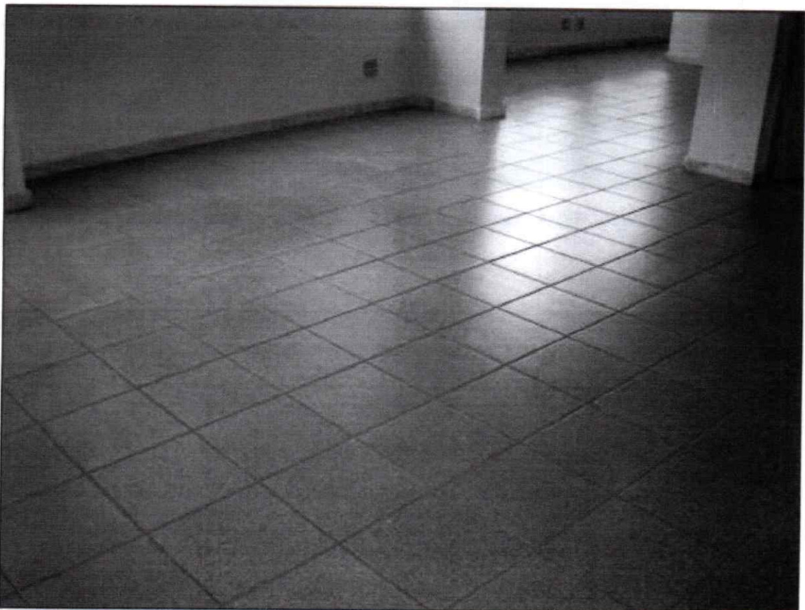
Figura 3: Piso cerâmico em excelente estado.
