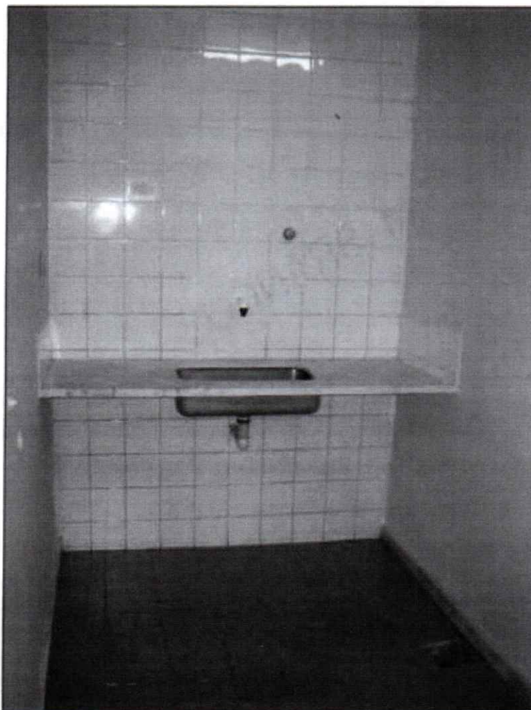
Figura 20: Copa 1º pavimento.
