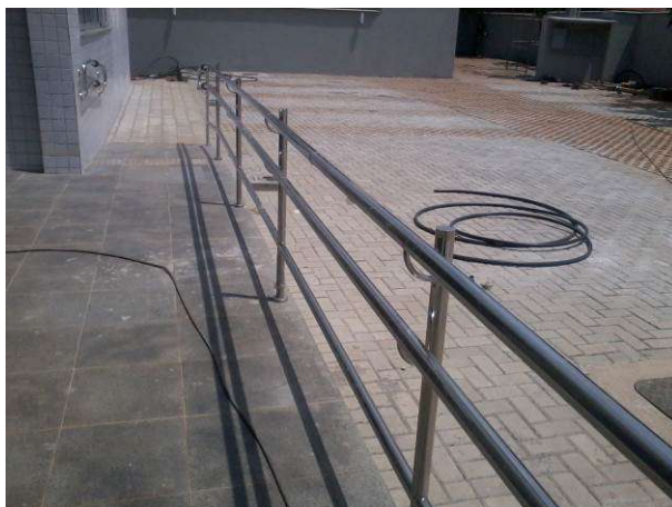
Detalhe corrimãos metálicos em aço inox
