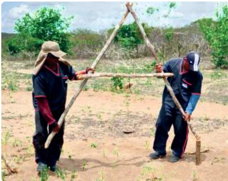
Nivele as duas estacas batendo com o martelo na estaca mais alta até que o prumo esteja no nível.
