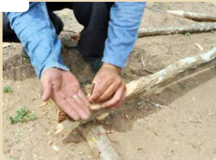
É recomendado que as estacas tenham um comprimento de 2 metros. (Caso você não tenha uma fita métrica, utilize uma pá que normalmente mede 1 metro de comprimento, as pernas devem ser de 2 vezes o comprimento da pá). Depois as pernas são colocadas uma em cima da outra pregando a 5 centímetros de uma ponta, (ou seja, 4 dedos).
