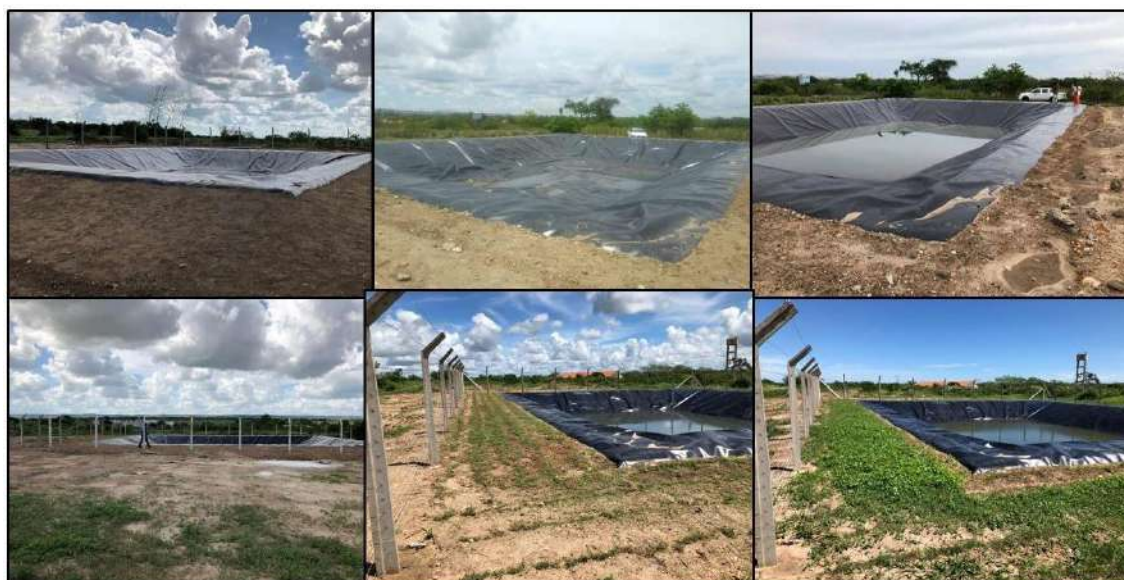
Figura 5. Reservatório de armazenamento das águas de reúso.
