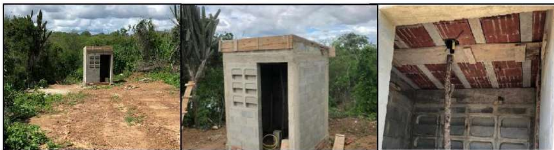
Figura 3. Casa da bomba do sistema de captação de efluente
