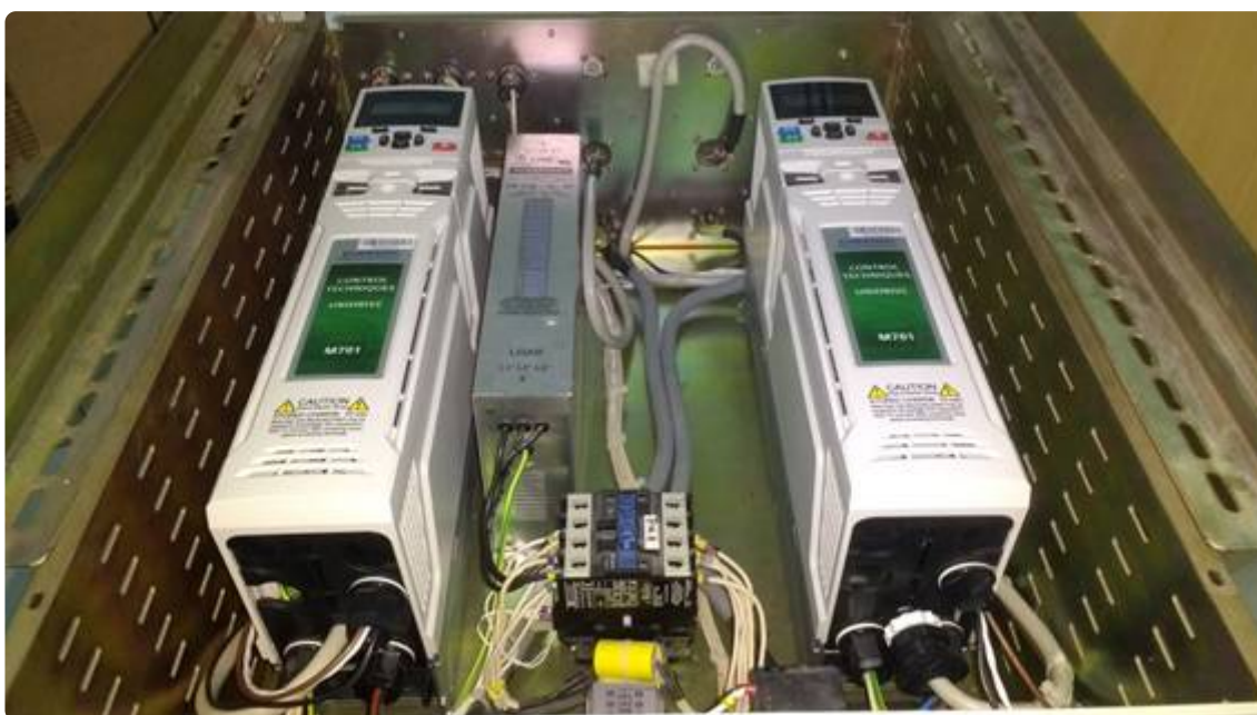
Figura 7: Drivers para o controle dos motores da antena parabólica da EMMN
