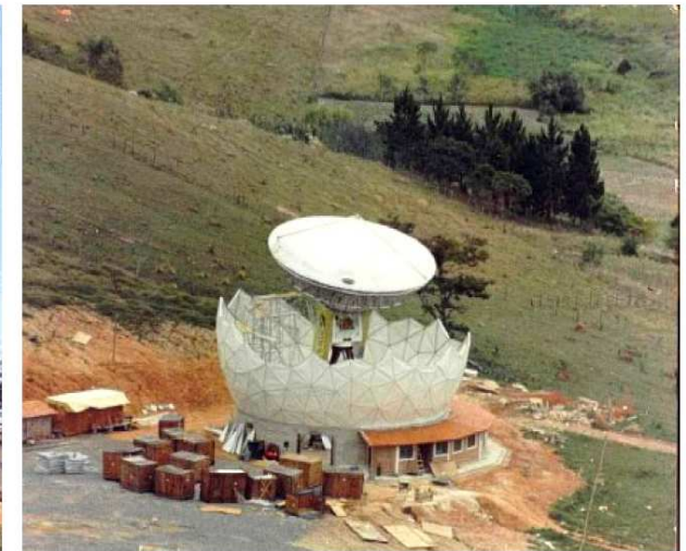
(b) início da montagem da redoma.
