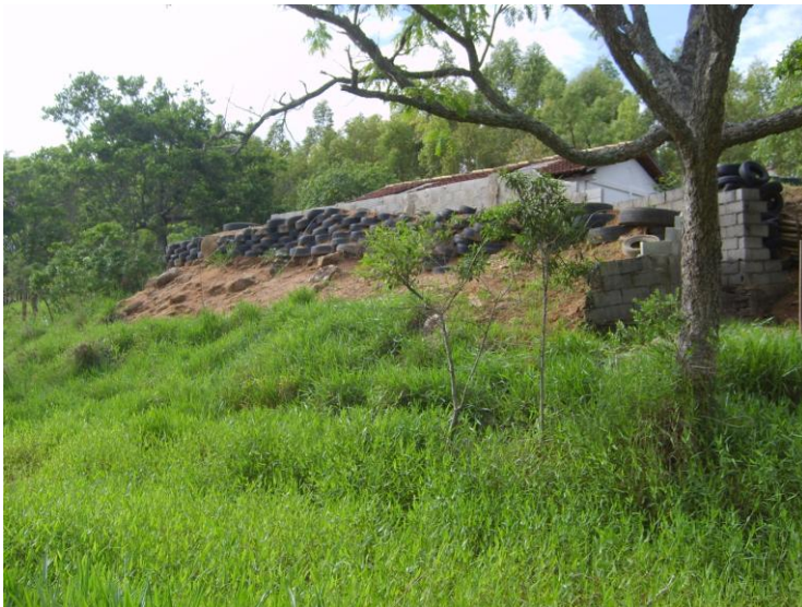
Foto 03: Depósito central (proteção com pneu para contenção em caso de explosão)
