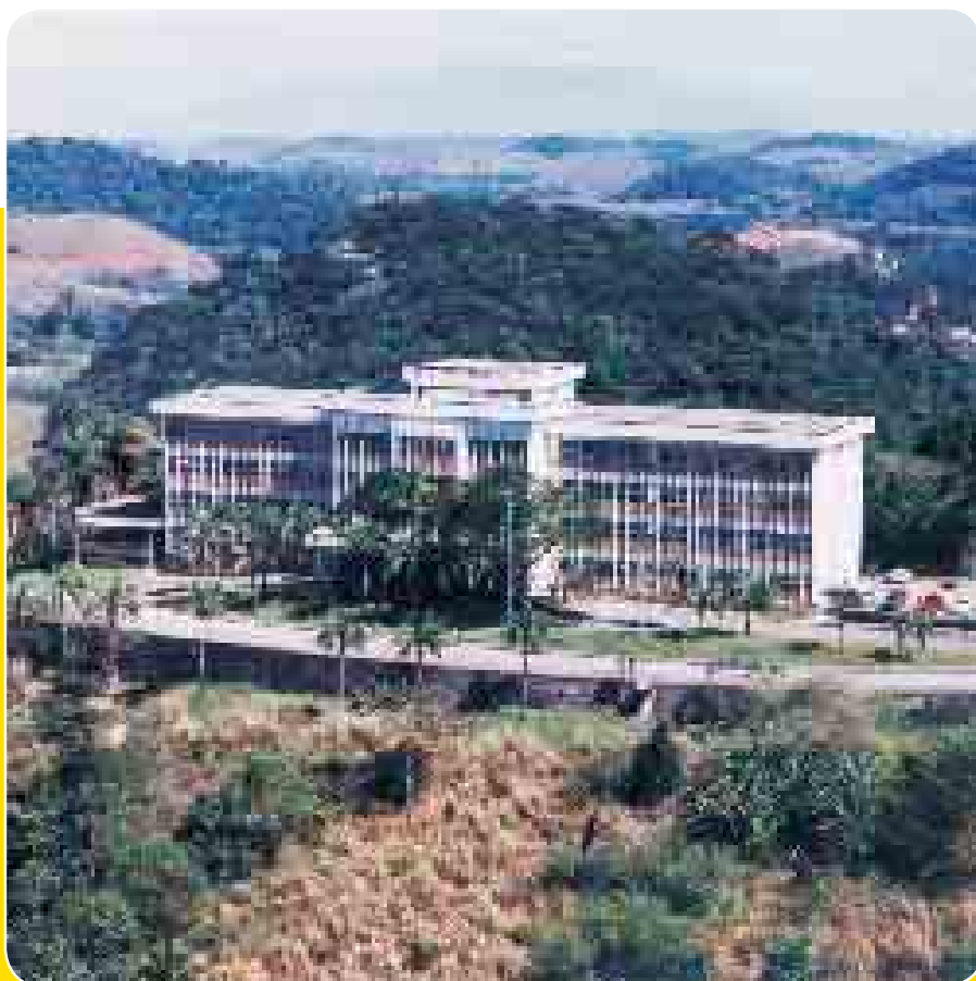
O Prédio 20 do campus de Xerém vai ser reformado para abrigar, como nos velhos tempos, toda a estrutura administrativa do Inmetro
