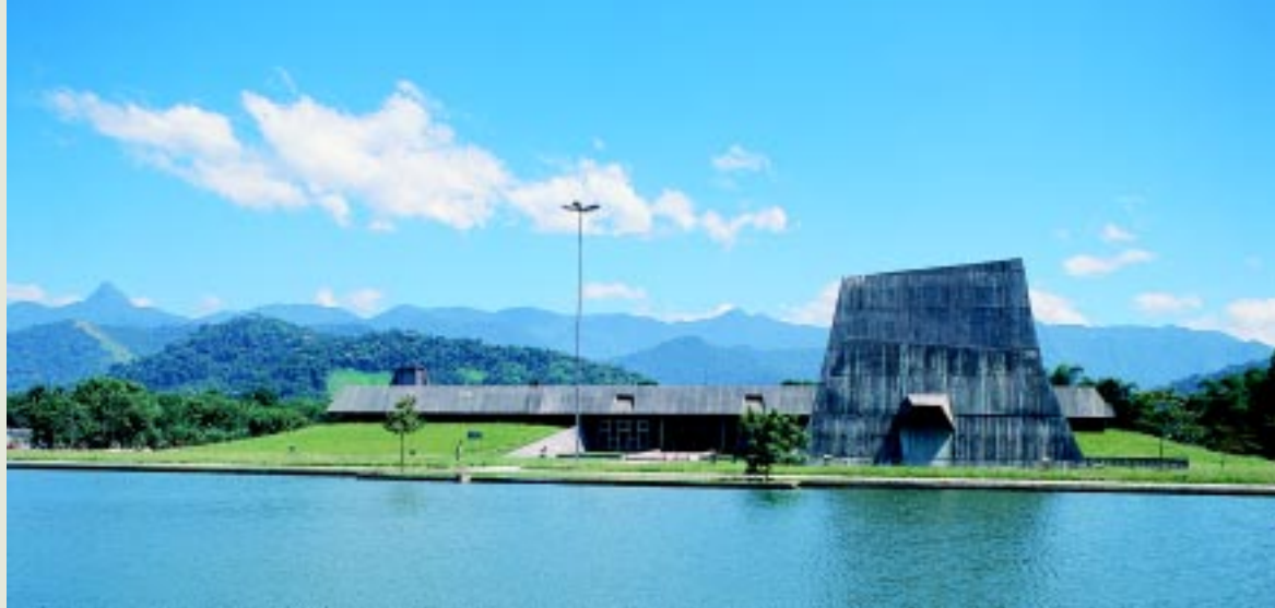
Divisão de metrologia elétrica do Campus de Xerém.
