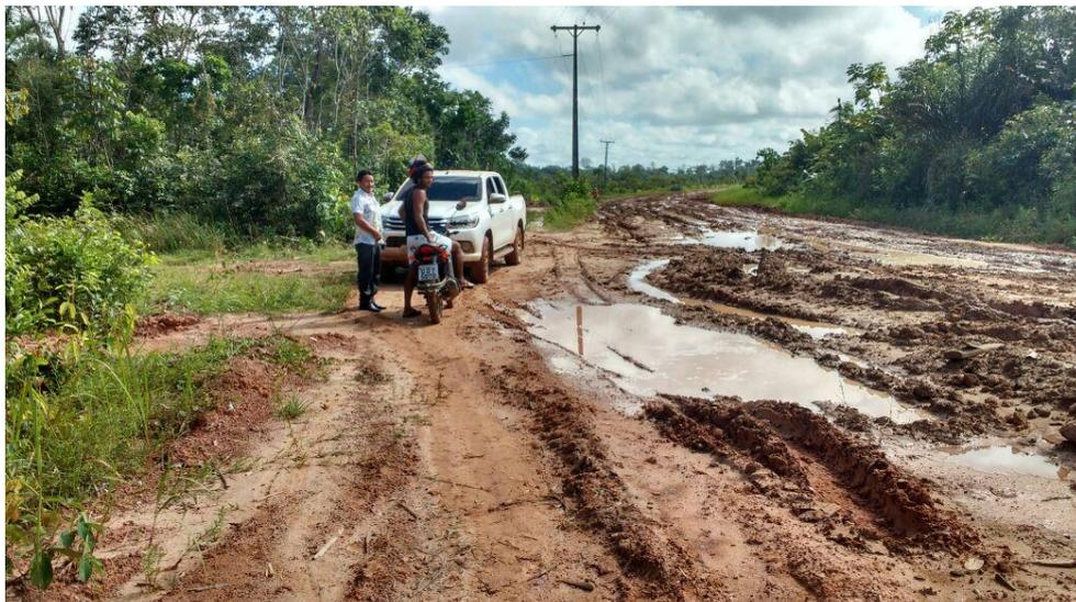
Figura 8: Pista de rolamento danificada por problemas de drenagem
