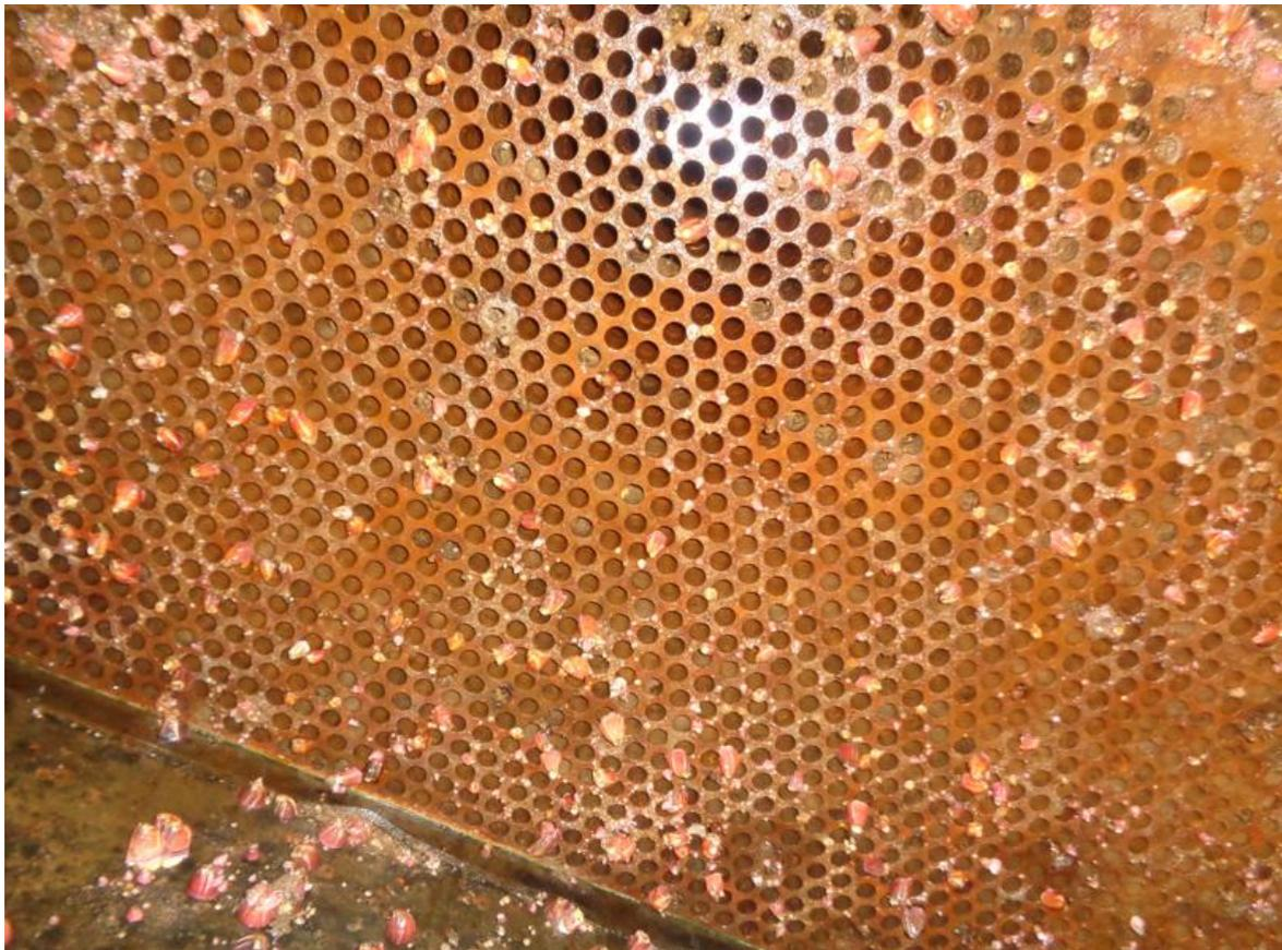
Figura 9: Incrustação de organismos marinhos no espelho dos tubos de trocador de calor
