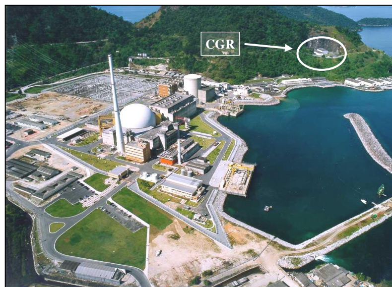
Figura 7: Localização do CGR Fonte: ELETRONUCLEAR (2022)
