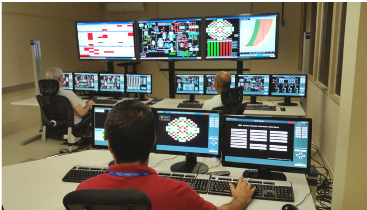
Figura 18: Vista parcial da sala de controle do LABIHS (IEN 2018)
