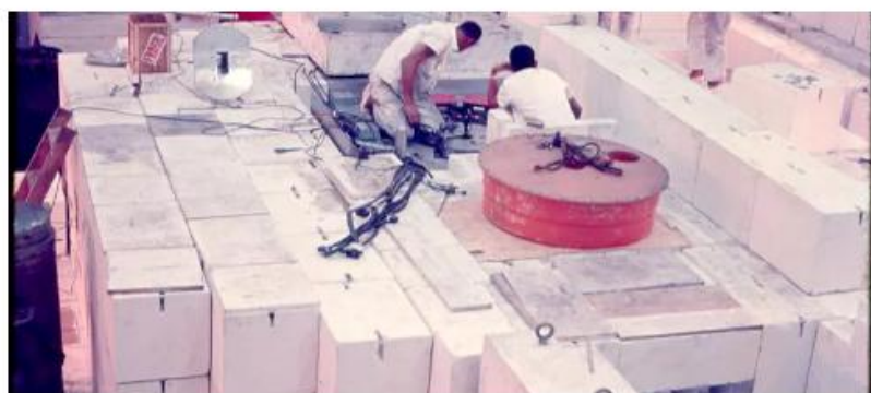
Reator em construção
