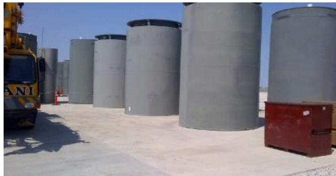
Figura 5: Recipientes de armazenamento a seco
