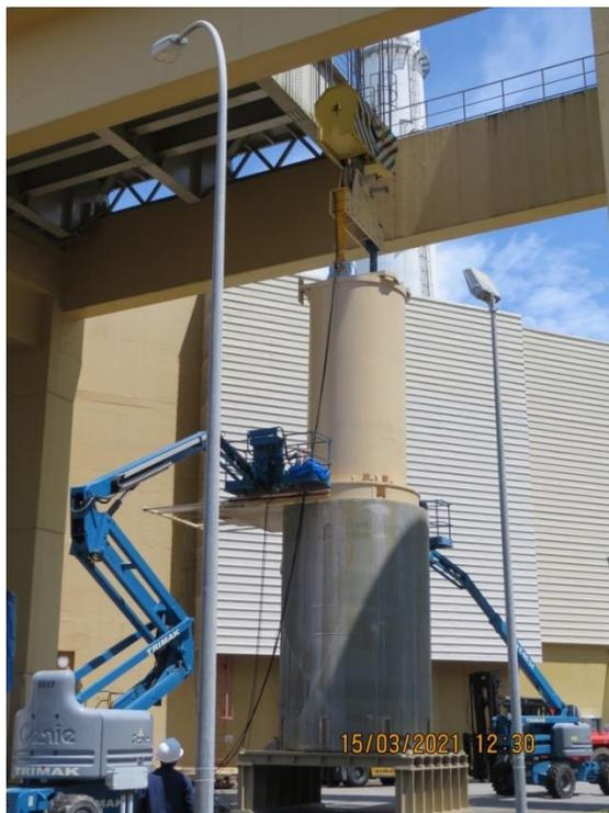
Figura 17: Posicionamento do HI-TRAC acima do HI-STORM
