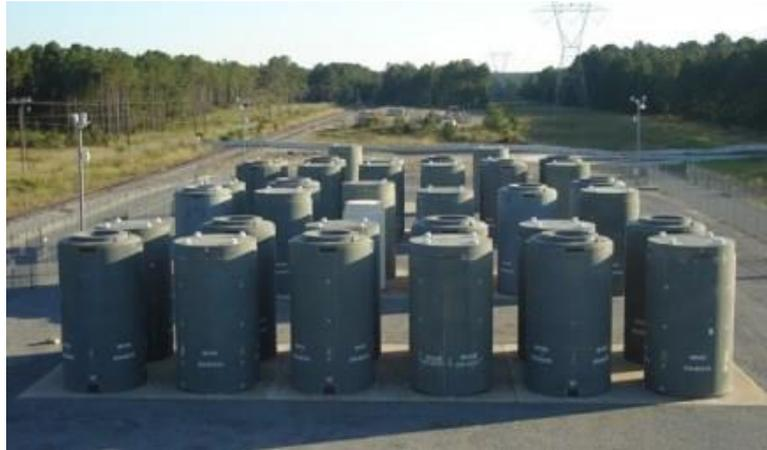
Figura 4: Recipientes de armazenamento a seco
