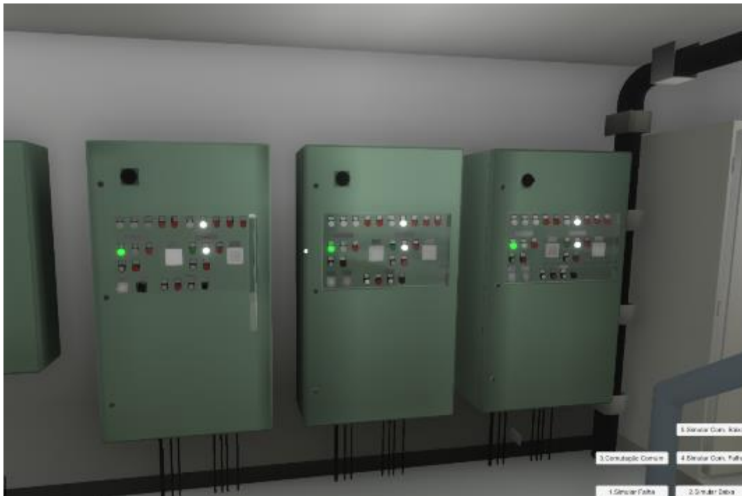
Figura 34: Reprodução dos painéis de comando para as bombas de óleo lubrificante no ambiente virtual
