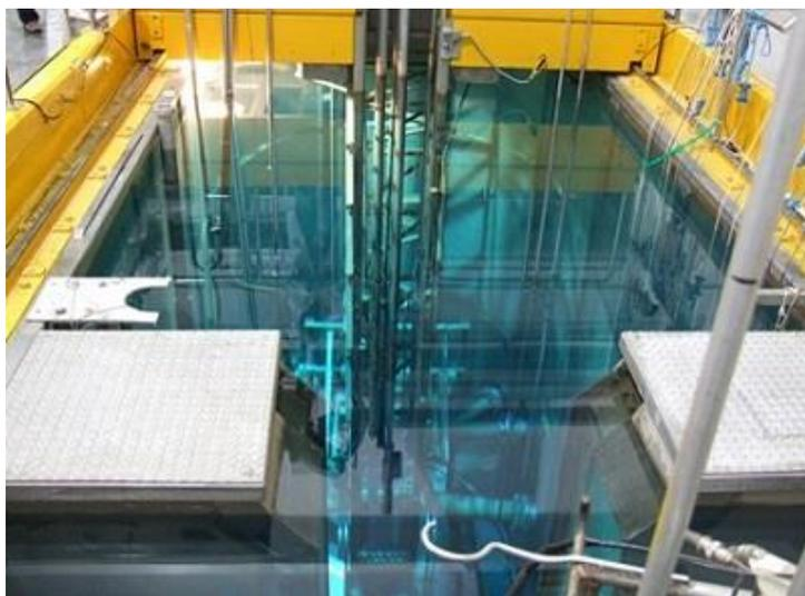
Figura 11: IEA-R1: piscina, núcleo do reator e outros elementos vistos de cima.
