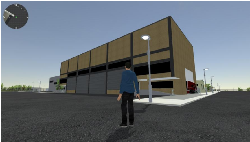
Figura 12: Edifício de Processamento de Rejeitos Radioativos
