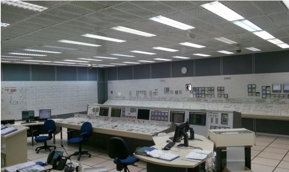
Figura 3. 3 - Sala de Controle do Simulador de Angra 2
