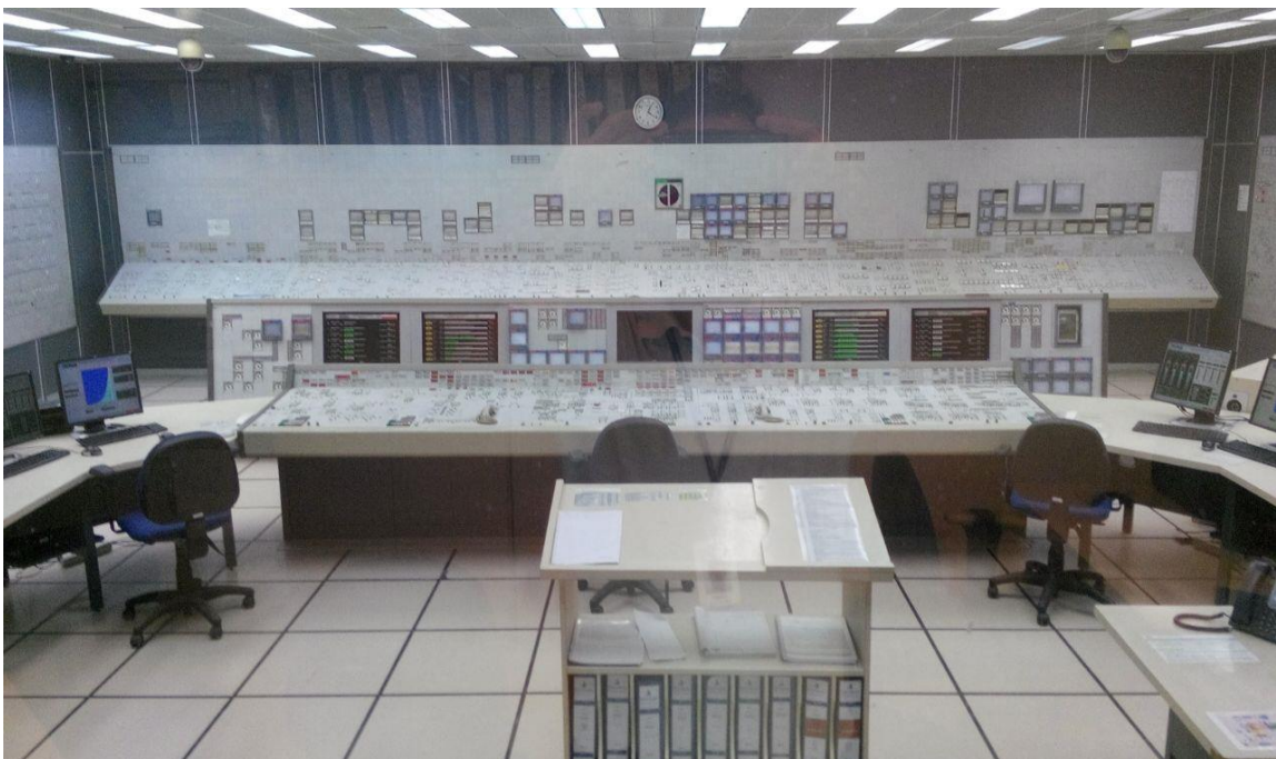
Figura 3. 4 - Sala de Controle do Simulador de Angra 2
