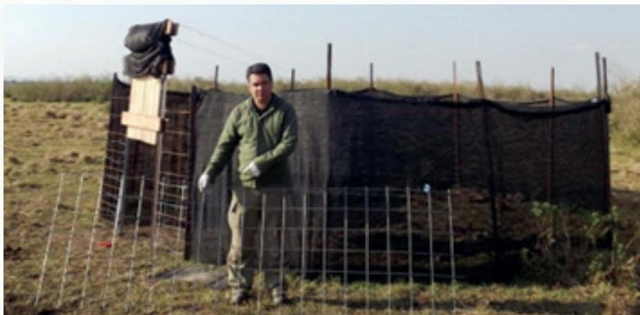
Figura 4: Malha de aço POP é colocada do lado externo dos mourões, sendo presa no fio de aço inferior e no fio de aço do meio.
