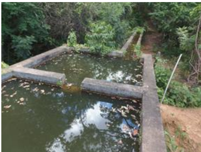
Figura 24: Caixa d'água no final do canal. Fonte: Acervo RBME
