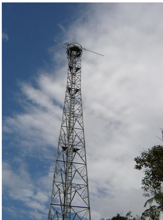
Figura 12: Torre Telemar na estrada para Mumbuca. Fonte: Acervo da RBME
