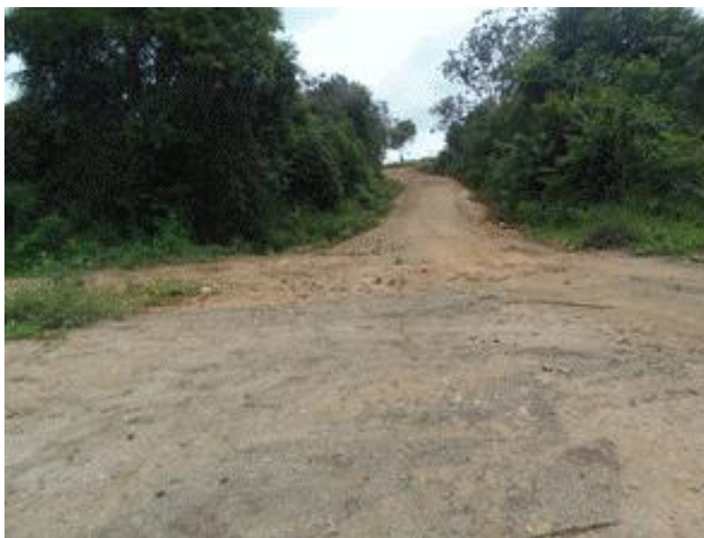
Figura 70: Córrego Vereda a montante da RBME, visão da estrada MG-105. Há uma tubulação que cruza a estrada para passagem de água. Fonte: Acervo da RBME
