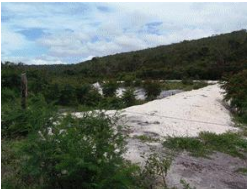
Figura 68: Barramento no córrego Vereda a montante da RBME. Fonte: Acervo da RBME
