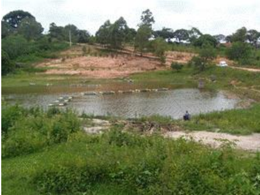
Figura 66: Barragem do PA Craúno, localidade Fazenda Nova. Fonte: Acervo da RBME
