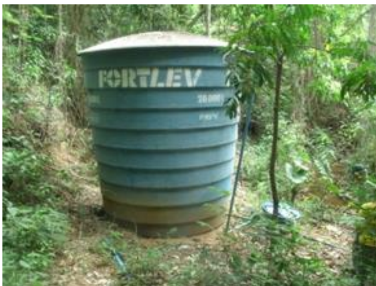
Figura 27: Caixa d'água comunitária do sistema de abastecimento de água tratada administrado pela associação local de moradores (20.000 litros). Fonte: Acervo RBME.
