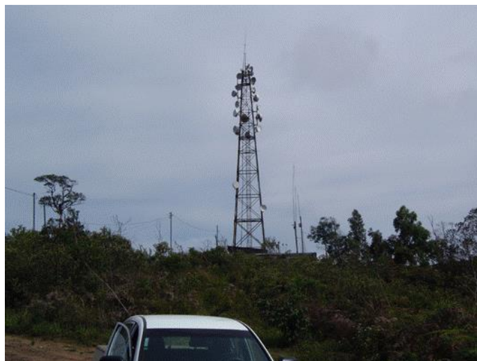
Figura 10: Torre Detel. Fonte: acervo da RBME
