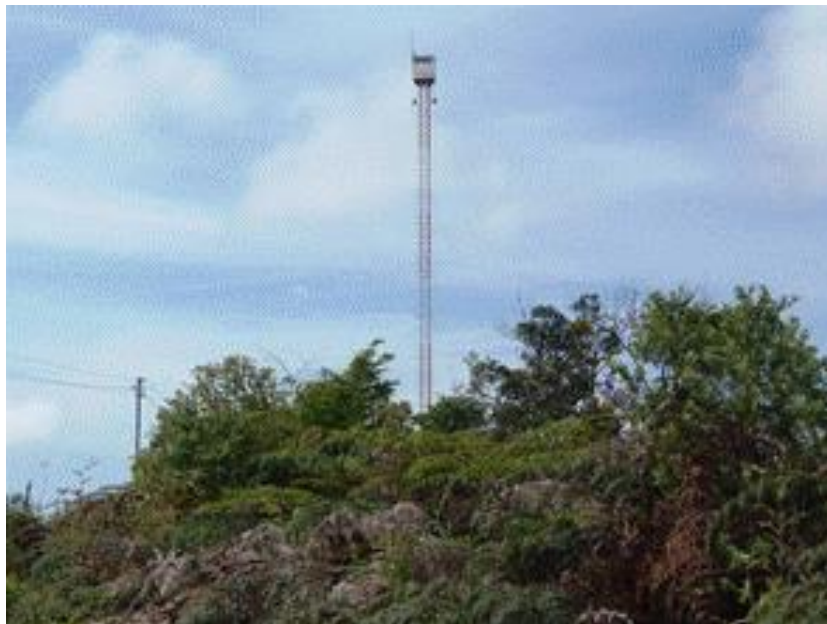
Figura 63: Torre de incêndio. Fonte: Acervo da RBME
