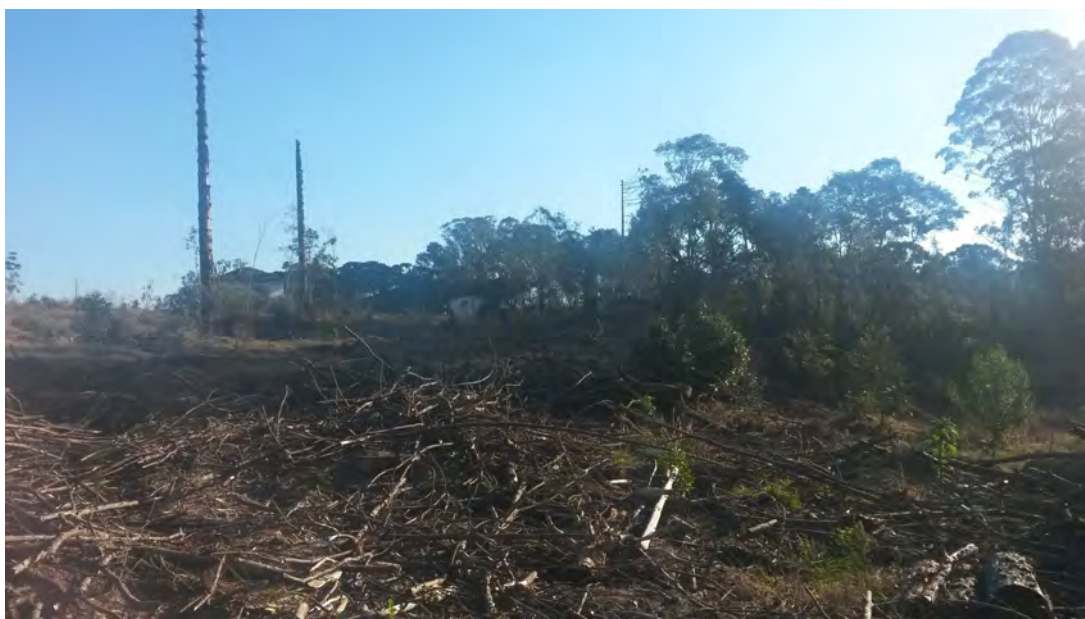
Figura 17 - Zona de Recuperação - Área 03, após o corte raso de pinus.
