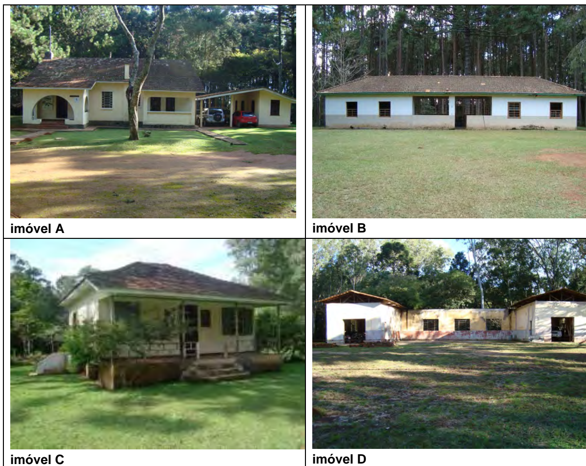
Figura 72 – Principais edificações na Flona: imóvel “A”, ocupado pelo Chefe da Flona; imóvel “B”, sede da Flona; imóvel “C”, alojamento de pesquisadores e imóvel “D”, garagem/depósito
