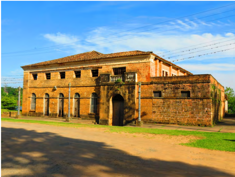
Figura 5.1.5.1-2: Casa da Guarda, concessão destinada a café e restaurante.
