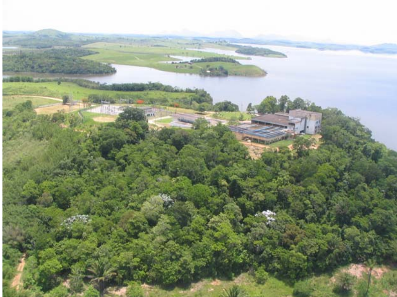
Figura 2.28 – Estação de tratamento de água da concessionária Águas de Juturnaíba
