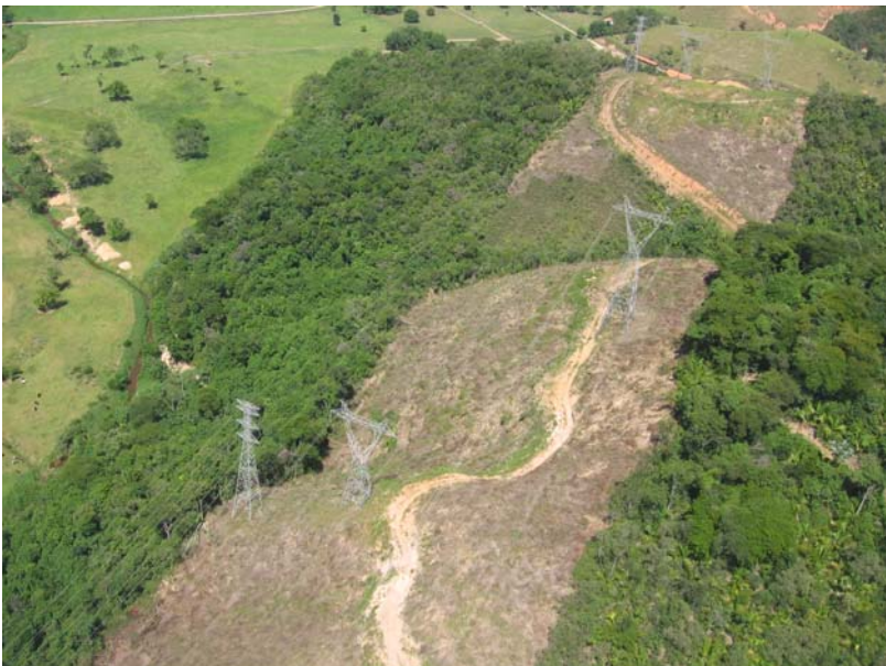
Figura 2.77 – Limpeza da faixa de servidão de linha de transmissão de energia dentro da APA
