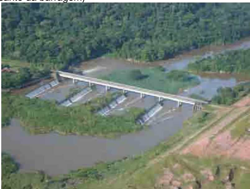
Figura 2.27 – Represa de Juturnaíba (notar formação de pequena ilha a jusante da barragem)
