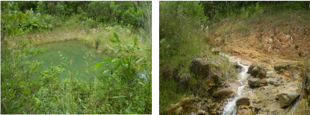
Figura 14 - A - Lagoa de origem antrópica, localizada próxima ao talude da estrada de acesso à RPPN. B - Curso d'água localizado no local da lagoa que se rompeu.
