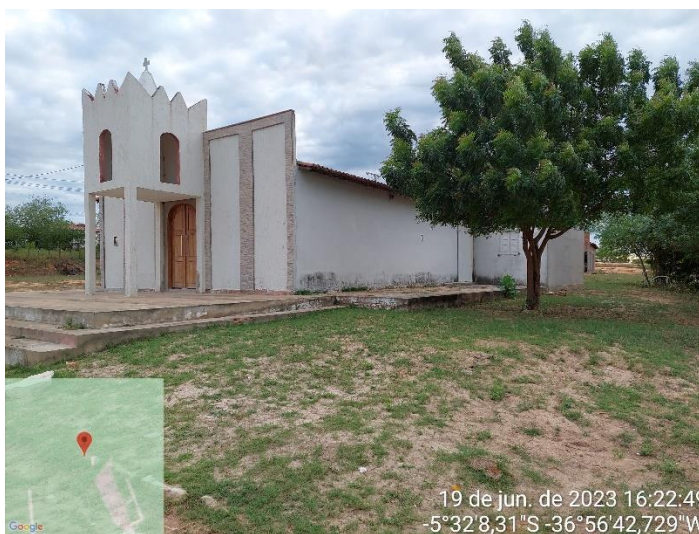
Figura 33: Igreja na comunidade Porto do Piató.
