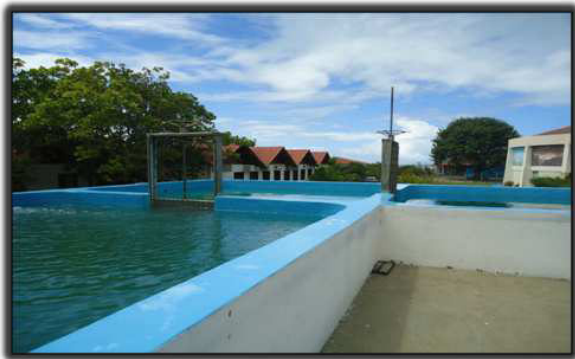
FIG.4-VISTA DOS OCEANÁRIOS EM “L”
