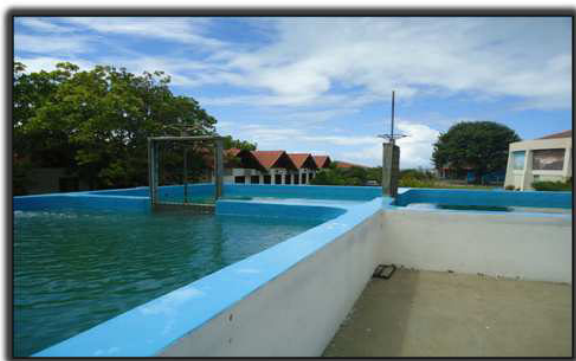
FIG.4-VISTA DOS OCEANÁRIOS EM “L”
