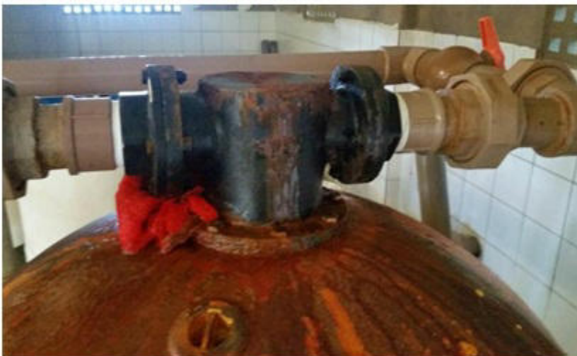
Foto 4 – Detalhe da válvula de 2 1/2"
