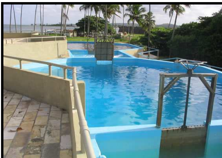
Figura 1 – Vista dos oceanários de visitação.
