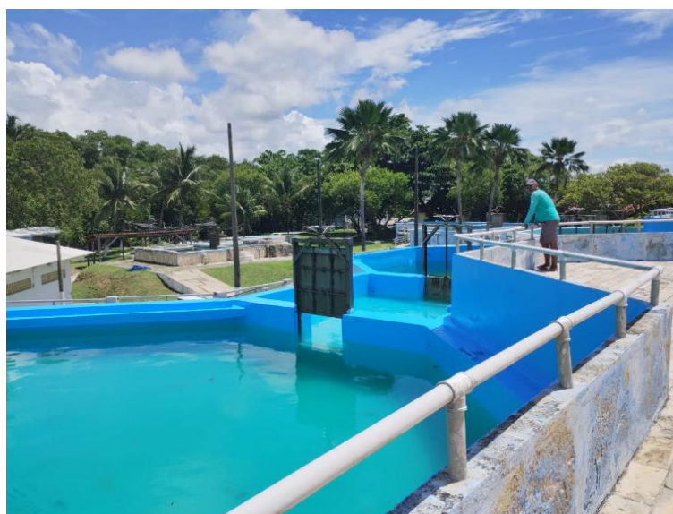
Figura 10 - Plataforma de observação dos oceanários com área de cuidados intensivos ao fundo.
