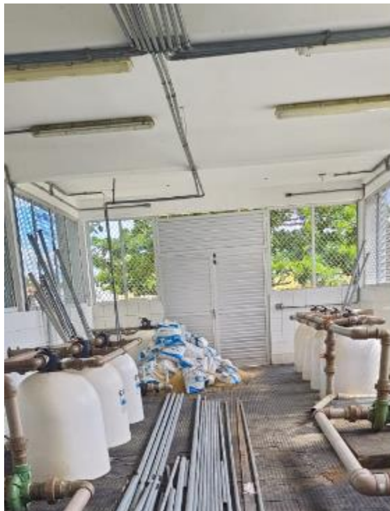
Figura 24 – Estrutura de apoio (casa de bombas 3).
