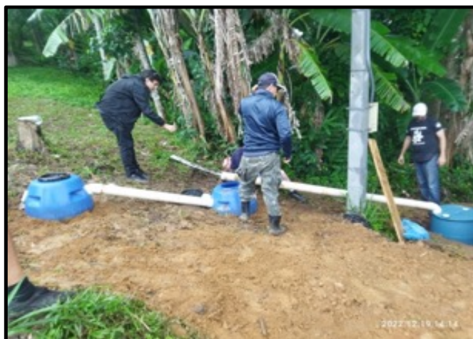
Fotos 3 e 4 - Reatores Anaeróbios Biodigestores Artesanais instalados na comunidade de Eufrasina.
