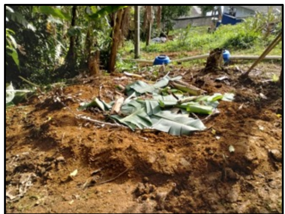
Foto 6 - Roda de bananeira para tratamento complementar
