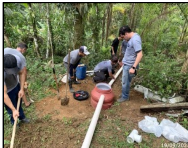
Fotos 3 e 4 - Reatores Anaeróbios Biodigestores Artesanais instalados na comunidade de Eufrasina.
