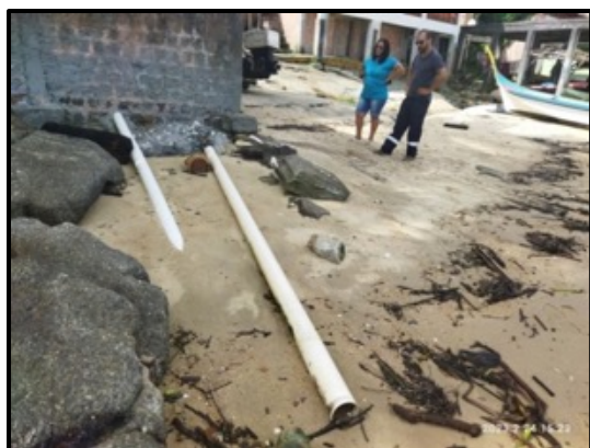
Fotos 1 e 2 - Tubulações de esgoto expostas na comunidade de Eufrasina.
