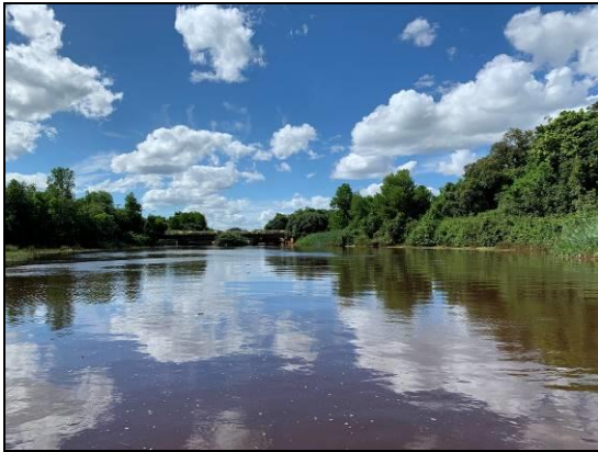
Figura 7. Ponto ERR 01R localizado próximo à comporta/barragem móvel.
