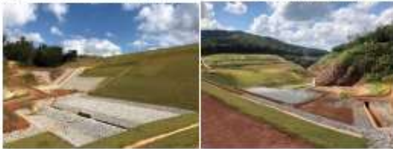
Figura 4 – Barragem Nova Santarém Fonte: AECOM, 2018.
