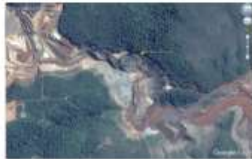
Figura 11: Situação da garganta do Trecho 3 em 2018.
