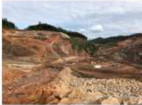
Figura 2: Local de construção do Dique Erso 1
