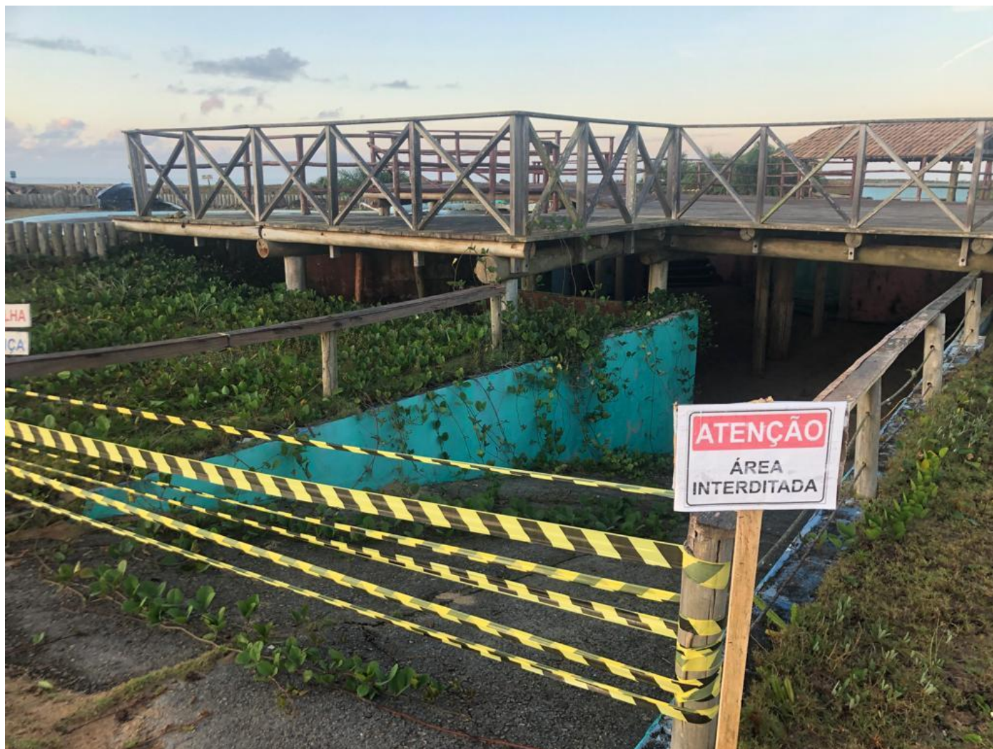
Figura 02. O madeiramento do deck, que já está instalado há 30 anos, precisa ser substituído, pois já não oferece segurança para os visitantes
