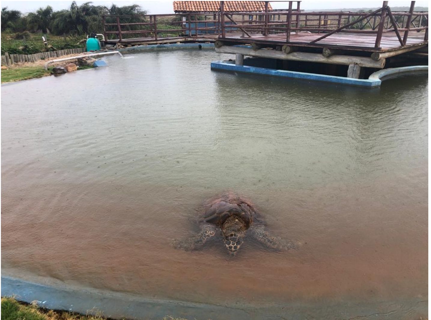
Figura 01. A acresção de areia registrada no ponto de captação de água para os tanques das tartarugas marinhas ocasiona uma diminuição da salinidade, o que gera a proliferação de água e o escurecimento da parede dos tanques; é necessário reposicionar o sistema de captação.
