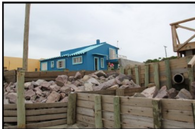
FIG. 10 – estrutura vertical de proteção, tipo mureta.
