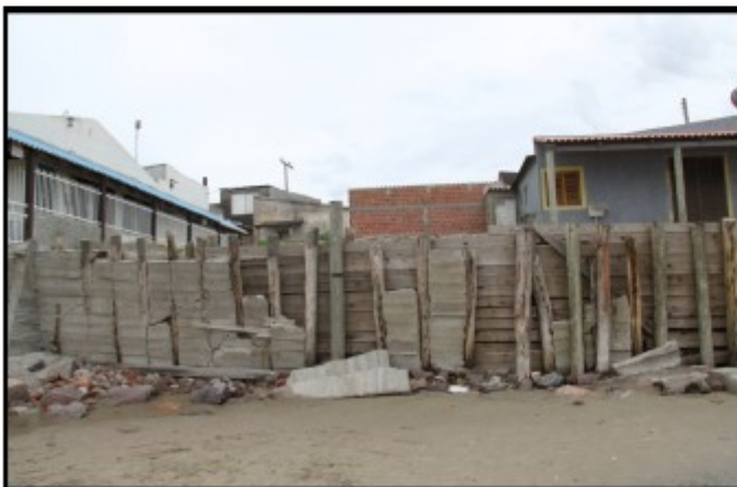
FIG. 09 – estrutura vertical de proteção, tipo mureta.
