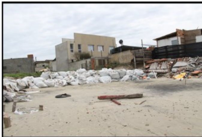
FIG. 29 – Sacos de areia, alguns sacos estavam com cimentos, se assemelhando a obra do tipo bagwall .
