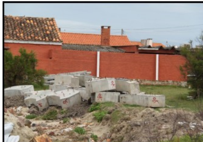
FIG. 28 – Blocos de concreto, pré-fabricados, utilizados geralmente para contenção de taludes; no local, serão usados, provavelmente na construção de um muro de contenção.
