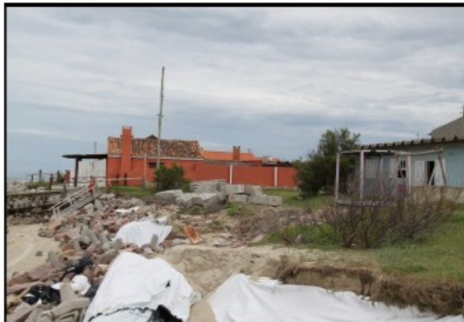
FIG. 27 – Estruturas de concreto, provavelmente peças de uma escada para dissipar as ondas ou para um muro.
