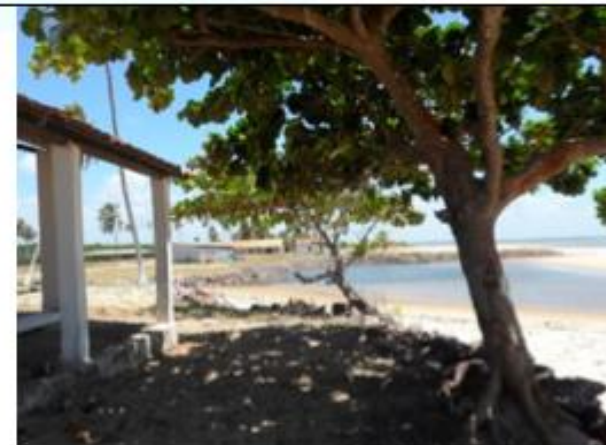
Ponto 06 – Barramento das marés com rochas
