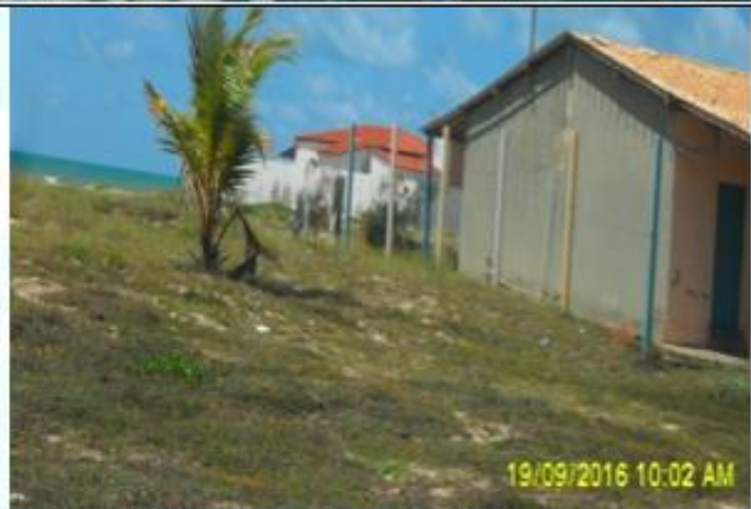
Ponto - A59 Ocupações na área não edificante
