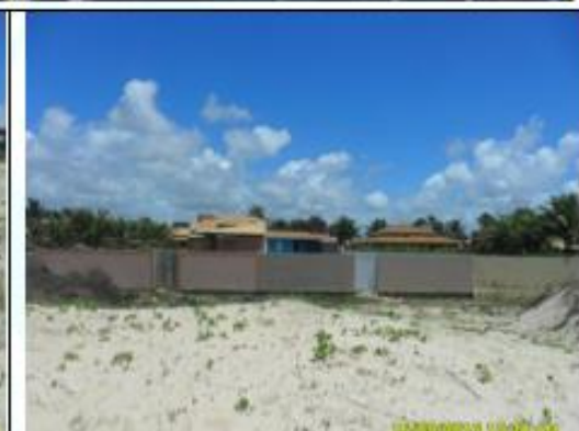
Ocupação em área não edificante
