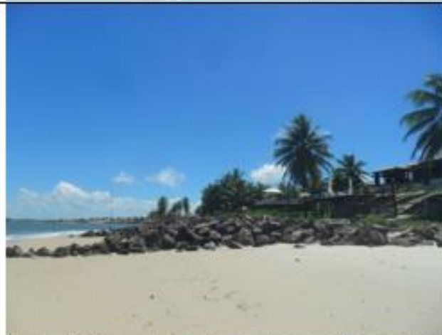
Ponto - 548 Ocupação irregular com barramento de rochas
