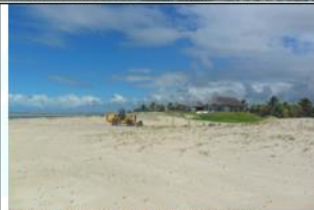
Ponto S40 Ocupação em zona não edificante
