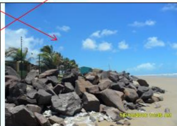
Ponto - C 60 Ponto de barramento com rochas
