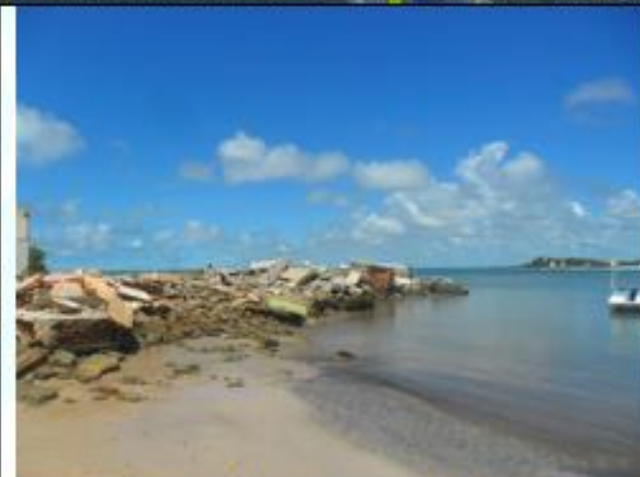
Ponto S67 Destruição de casas localizadas na zona de praia
