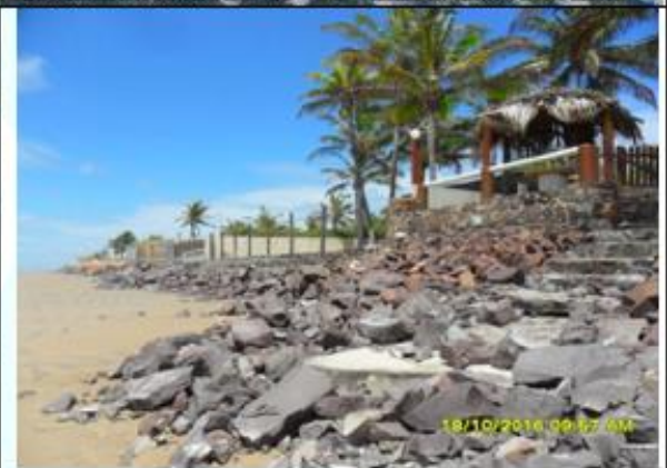
Ponto - C 46 Barramento da erosão marinha
