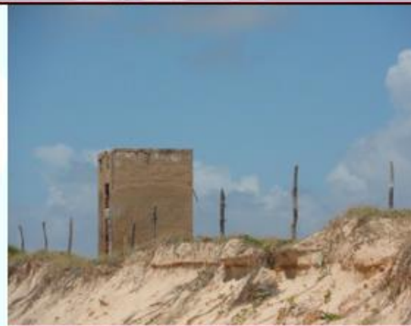
Ponto – 75 Construção em cima da duna
