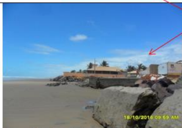
Ponto - C 47 –Ponto de derrubada de casas
