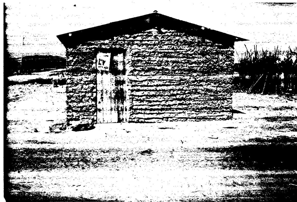
Projeto Brígida/Orocó - Casa de morador no lote de irrigação. Outubro/94
