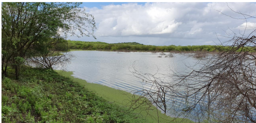
Figura 2 - Açude Santa Maria no município de Pão de Açúcar - AL
