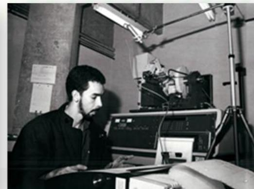
Com recursos do Banco Internacional para Reconstrução e Desenvolvimento (BIRD) a Divisão de Higiene do Trabalho (DHT) instala o laboratório de microscopia, gravimetria e difratometria de raios X. As metodologias analíticas são desenvolvidas e implantadas pelos pesquisadores engenheira Maria Margarida Teixeira Moreira Lima, química Alcinéa Meigikos dos Anjos Santos e físico Robson Spinelli Gomes, supervisionados pelo químico e chefe da DHT José Manuel O. Gana Soto.
