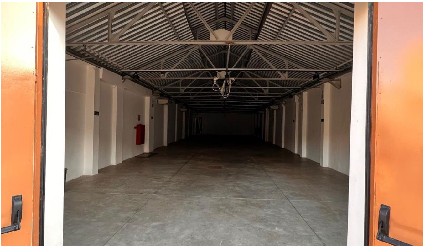
INTERIOR DO GALPÃO 05
