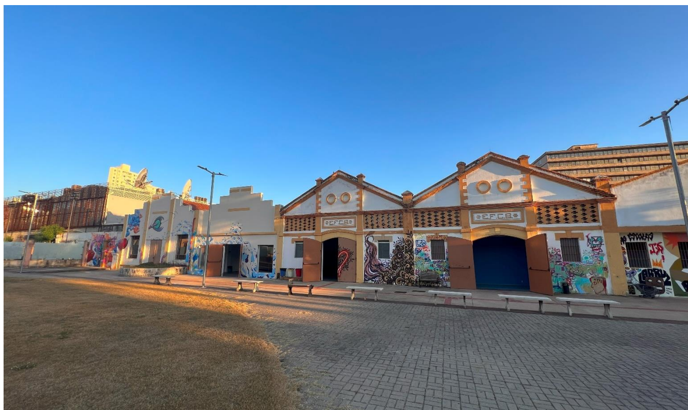
IMAGEM DA FACHADA DOS GALPÕES
