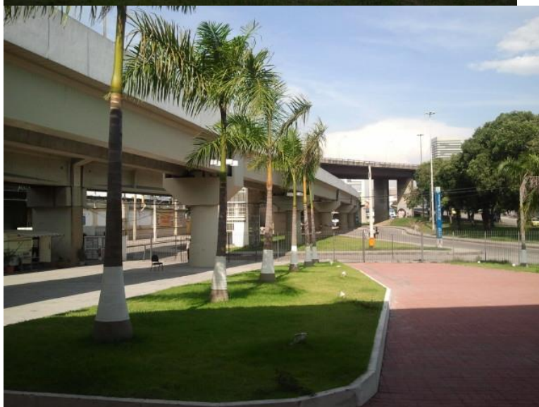
Visão da Câmera junto ao muro da SuperVia.
