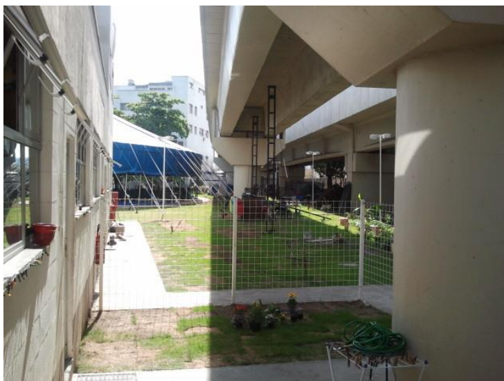
Visão da Câmera da Entrada Principal próximo a Radial Oeste
