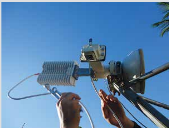
Figura 52: Cabos coaxiais: TX vermelho (BUC) e RX azul (LNB)
