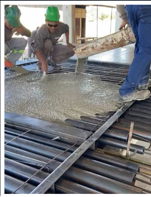
Concretagem dos Painéis
