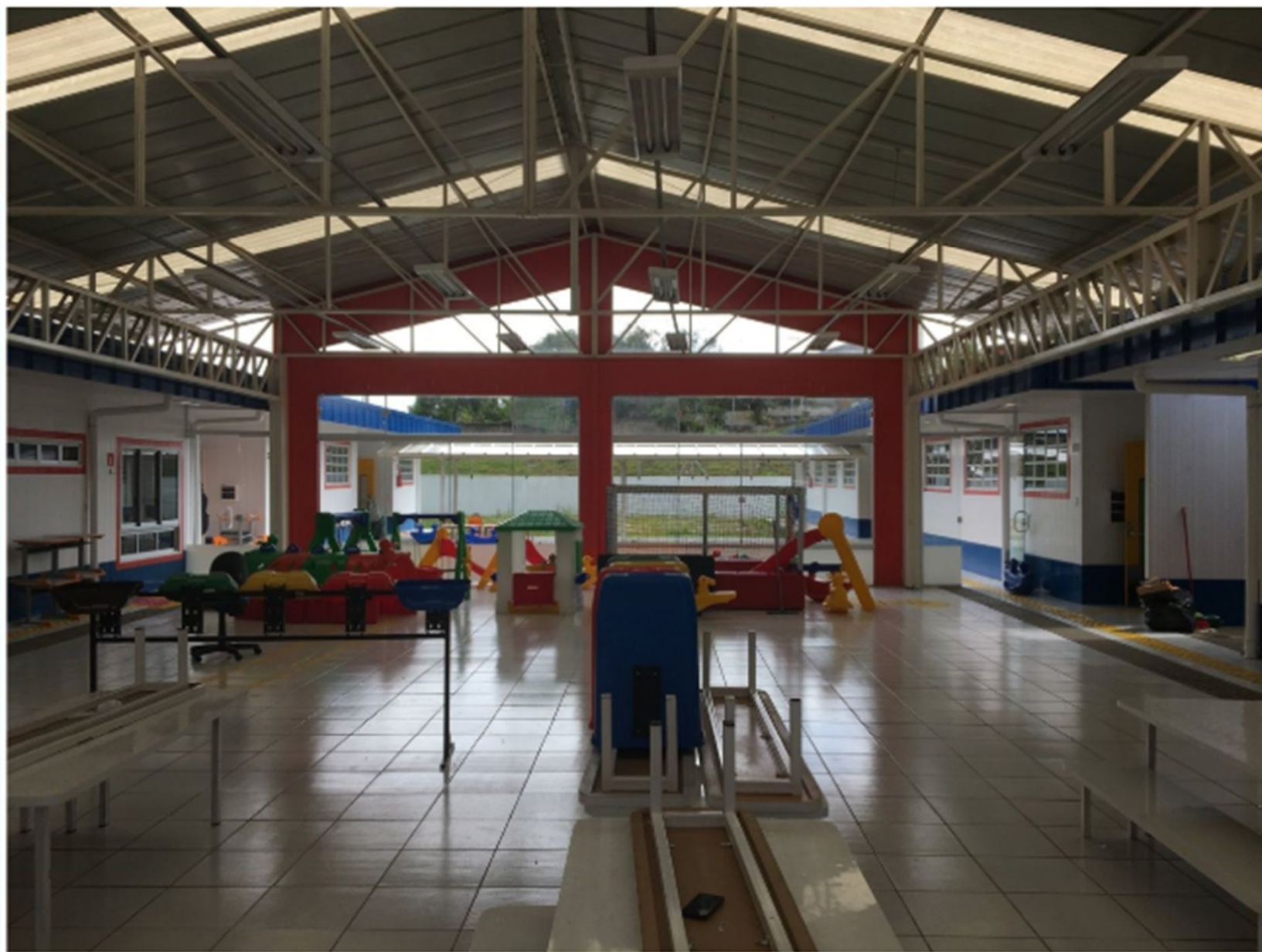
Creche MI em funcionamento em Colombo - PR
