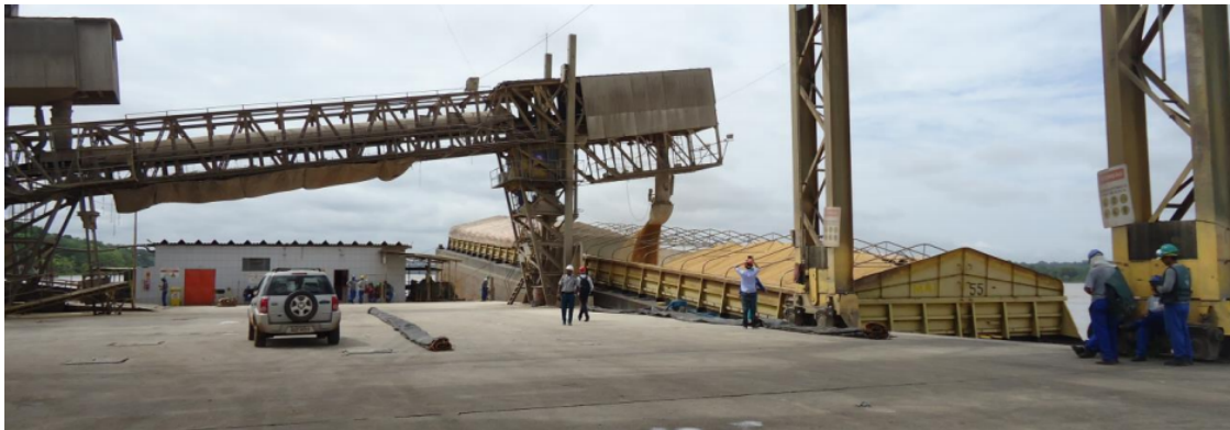
Figura 11 - Cais flutuante: embarque de grãos (Fonte: LabTrans, 2014)
