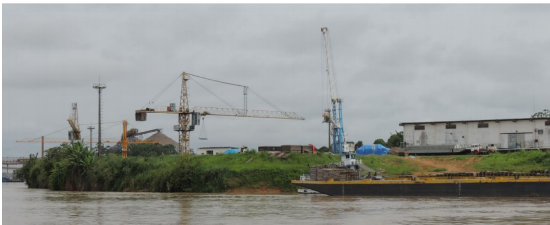
Figura 9 - Pontos de acostagem no pátio das guias (Fonte: LabTrans, 2014)
