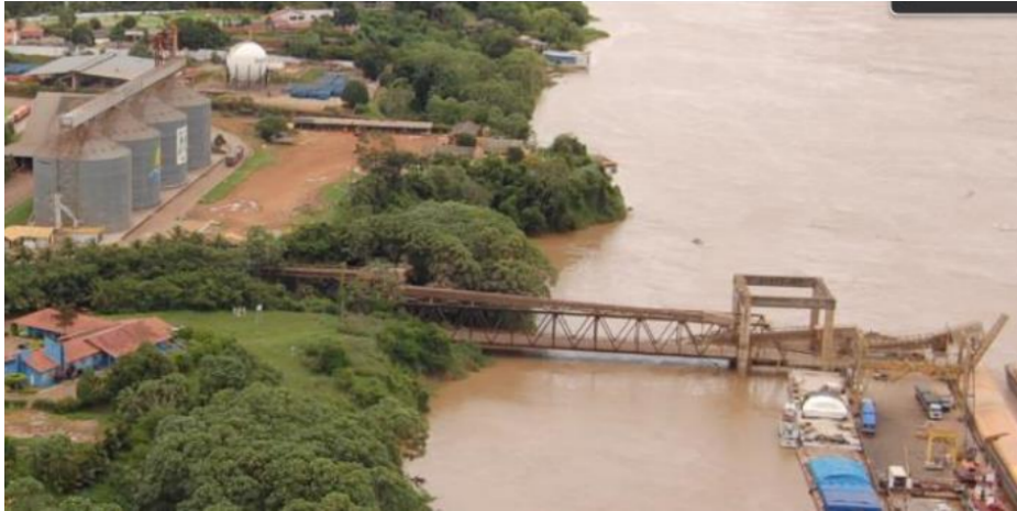
Figura 10 - Cais flutuante: visão aérea (Fonte: SOPH, 2018)
