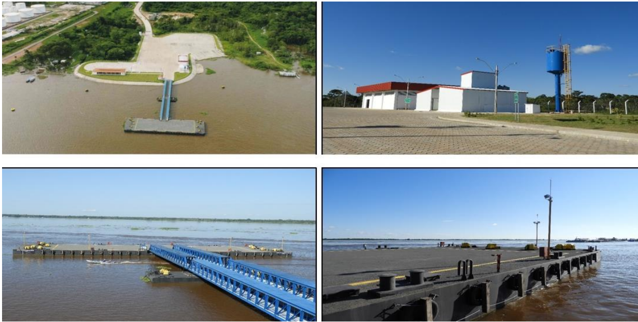
Fotos: DNIT. Nota: área de armazenagem e qualidade das infraestruturas construídas.
