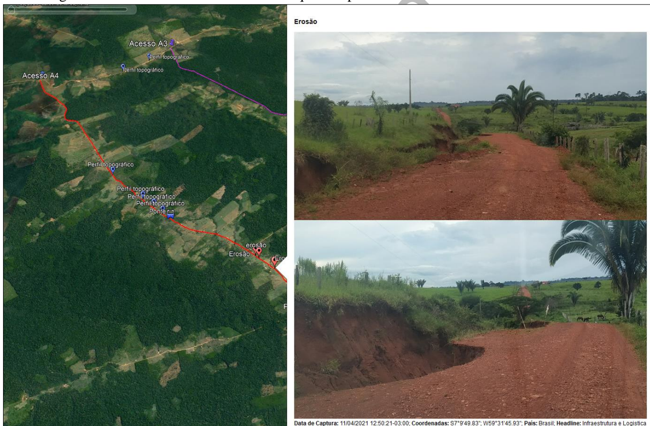
Figura 13. Acesso 4 - Processos erosivos que comprometem a infraestrutura e acesso à AMF.
