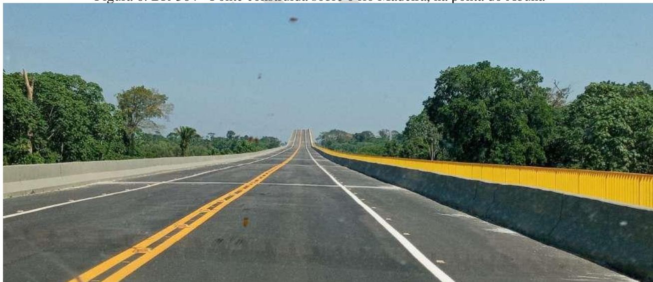
Figura 6. BR-364 - Ponte construída sobre o rio Madeira, na ponta do Abunã
