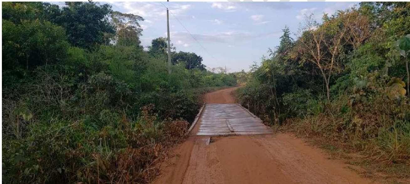
Figura 25. Uma das 19 pontes existentes no ramal 52 até o km 35
