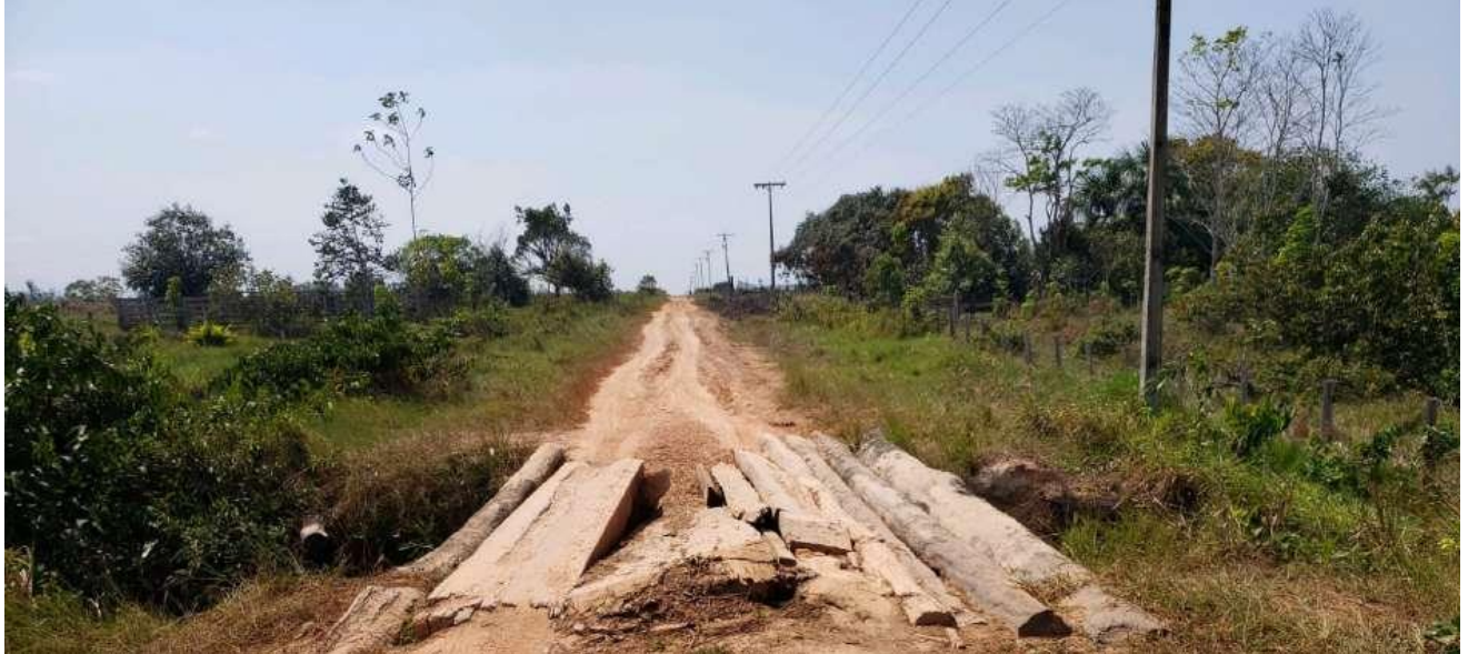
Figura 27. Vista da linha de transmissão padrão bifásico que vai até o km 47
