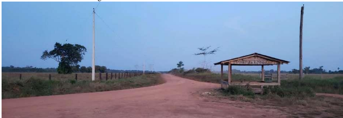
Figura 18. Entrada do ramal da fazenda Palotina I
