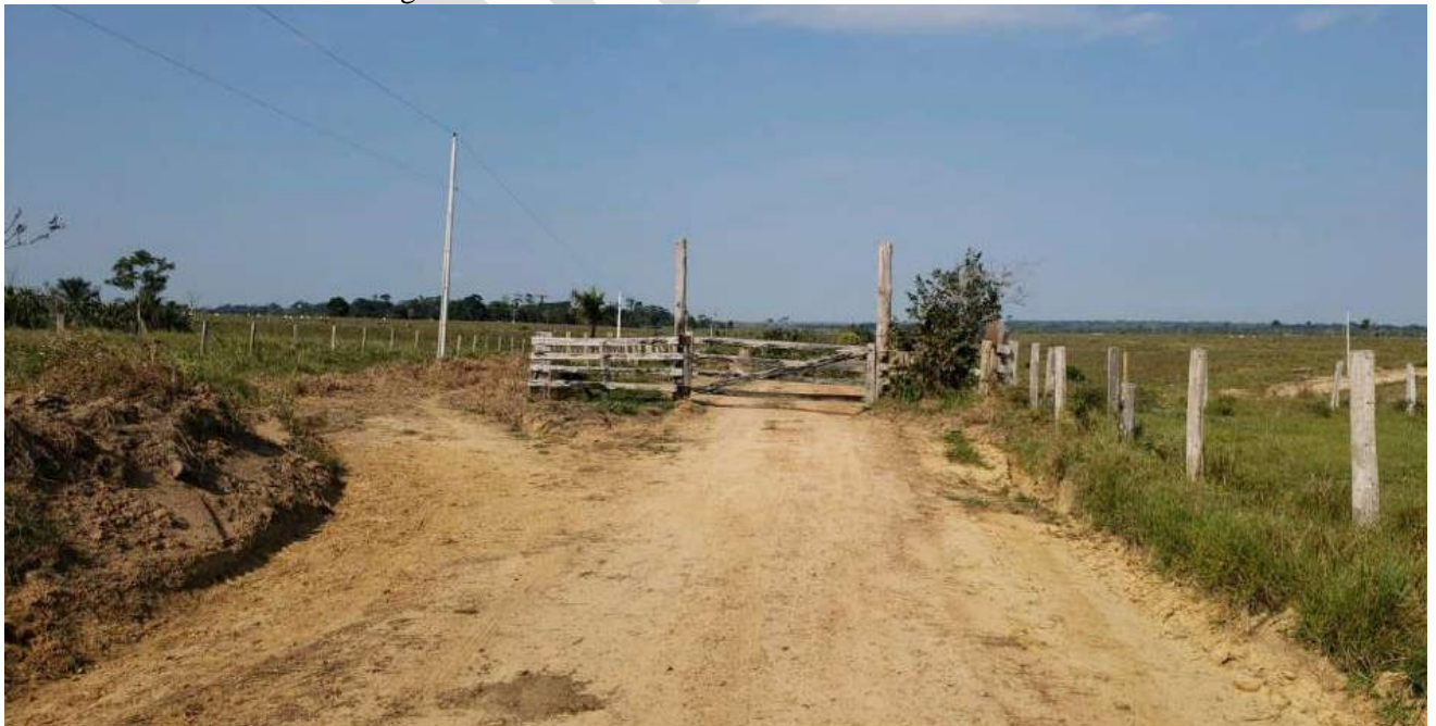
Figura 16. Trecho do ramal Km 37/38 com desvio
