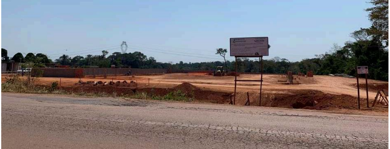
Figura 36. Área onde estão construindo a subestação de Nova Califórnia
