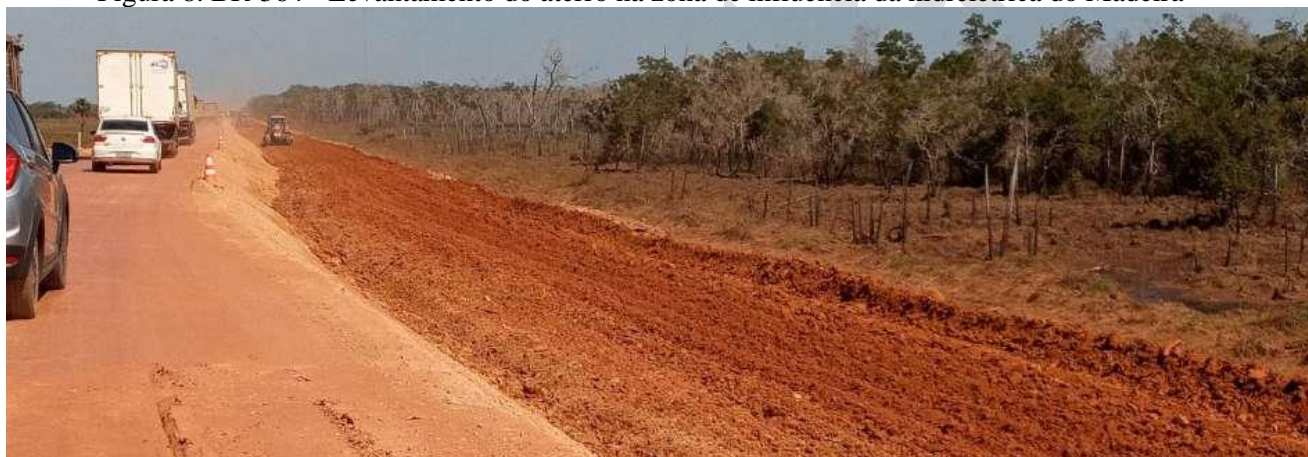
Figura 8. BR-364 - Levantamento do aterro na zona de influência da hidrelétrica do Madeira
