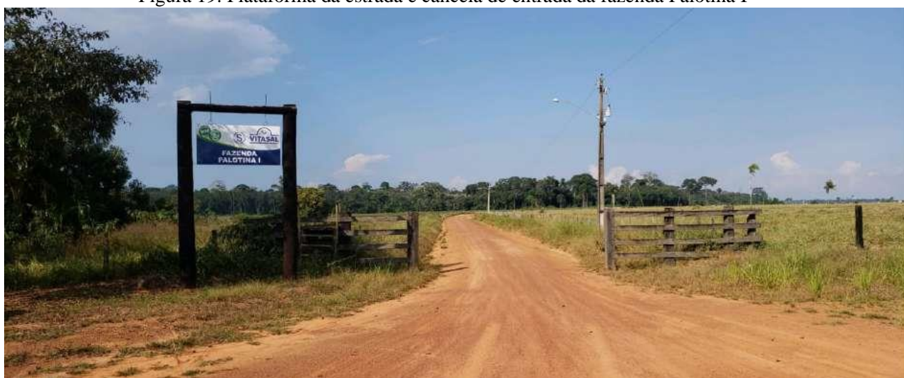
Figura 19. Plataforma da estrada e cancela de entrada da fazenda Palotina I
