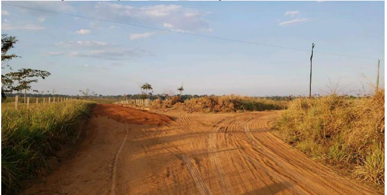
Figura 23. Bifurcação do ramal 52 no km 35, seguindo a direita rumo a Flona
