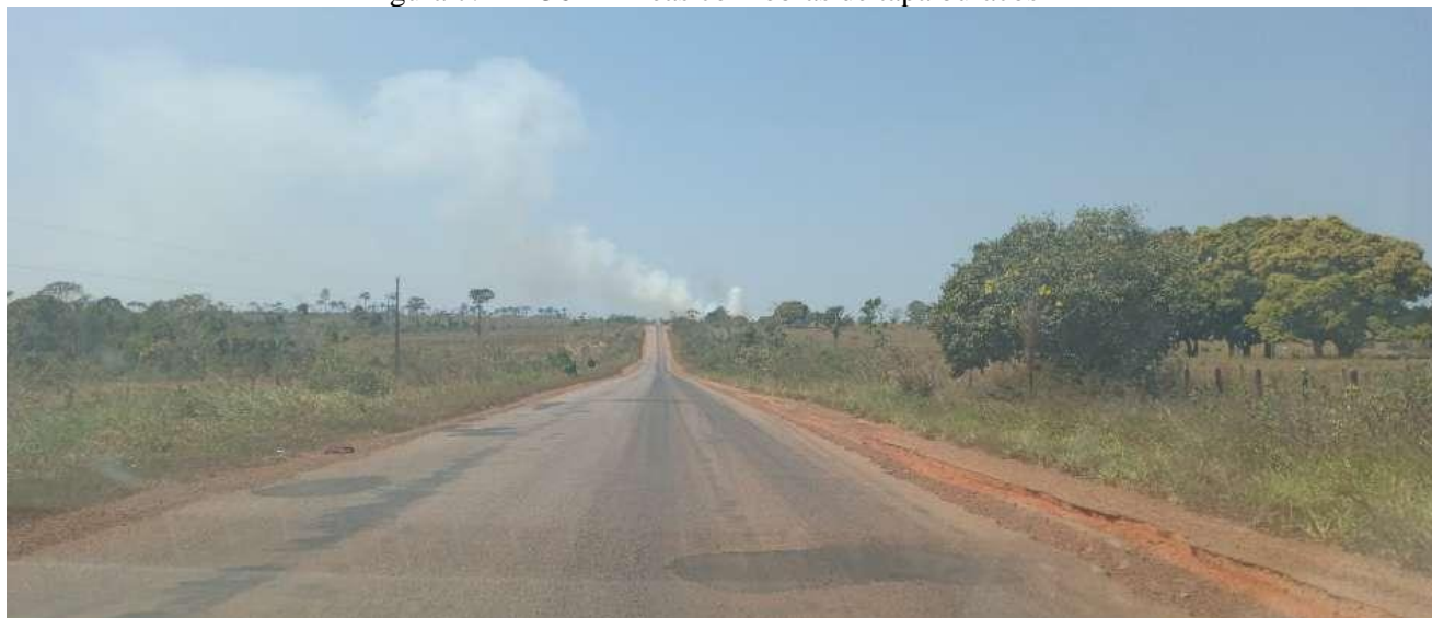
Figura 7. BR-364 - Áreas com obras de tapa buracos
